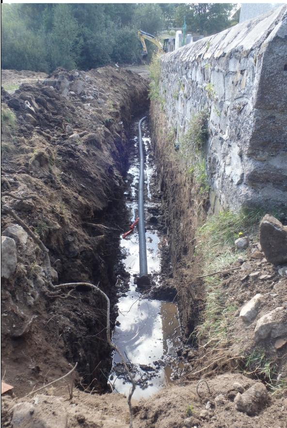
A l'occasion d'une nouvelle implantation de concession dans le nouveau cimetière, une fuite a été détectée au niveau des drains. Cette partie du cimetière est en effet particulièrement humide et des drains avaient été installés initialement.
